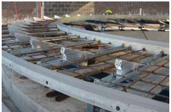
Reforço da plataforma de concreto, garante uma base forte e duradoura.
