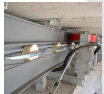
Viga dupla de transporte
