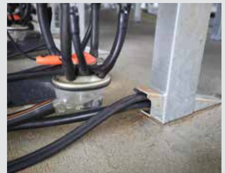
Configuração integrada de mangueiras na plataforma.
